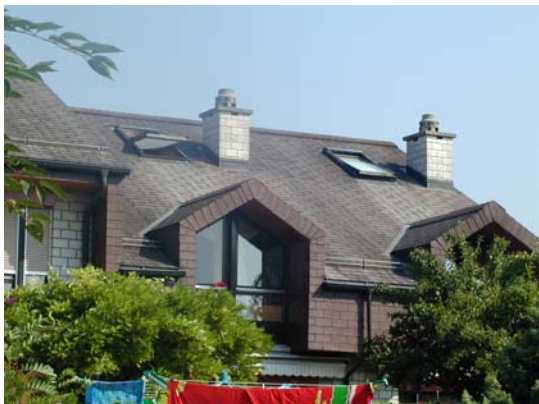
Dachschiefer aus Asbestzement, Foto: JMF/SLE, IST
