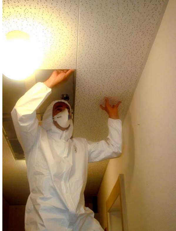
Abgehängte Deckenplatte (Akustikplatte), Foto: JMF/SLE, IST
